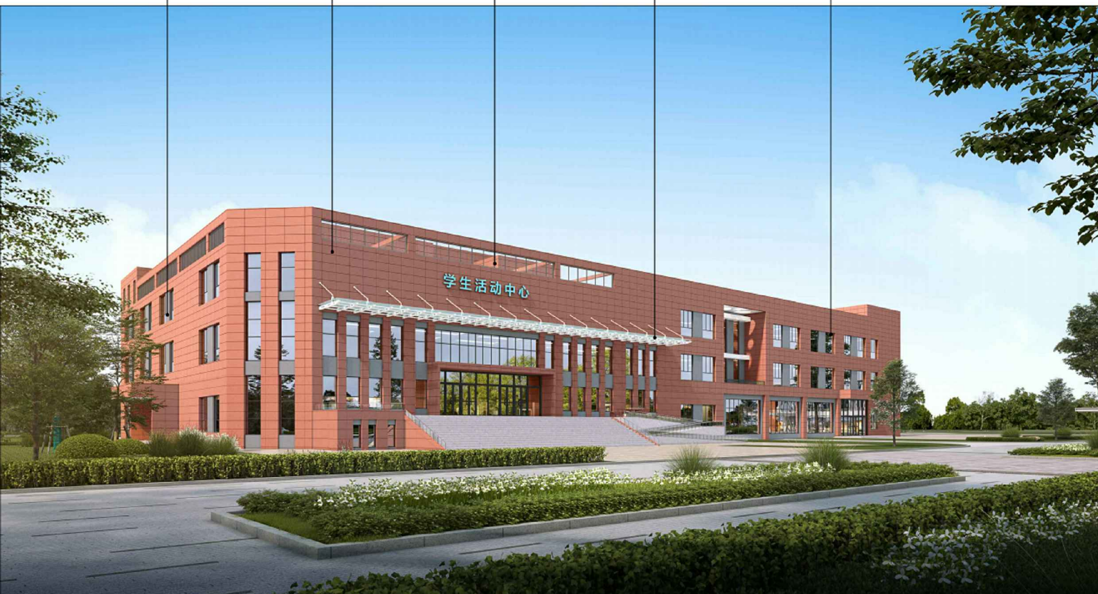
学生活动中心 西南面效果图 灰色干挂陶土板300X600 色卡号0551 千挂红色陶土板 300X600 色卡号0224 成品装饰百页（静电喷漆） 色卡号0551 铝合金玻璃雨棚 无色透明钢化玻璃 黑色铝合金框 无色透明LOW-E玻璃
