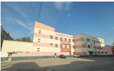
综合楼现状正面图
