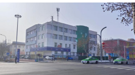
胜利街道办公楼改造前照片
